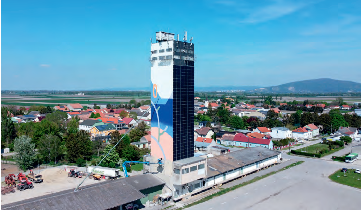
„Silosophie“ arbeitet an der Schnittstelle von Kunst und Ökologie und nutzt Silotürme für Projekte wie den „Vogelturm“
